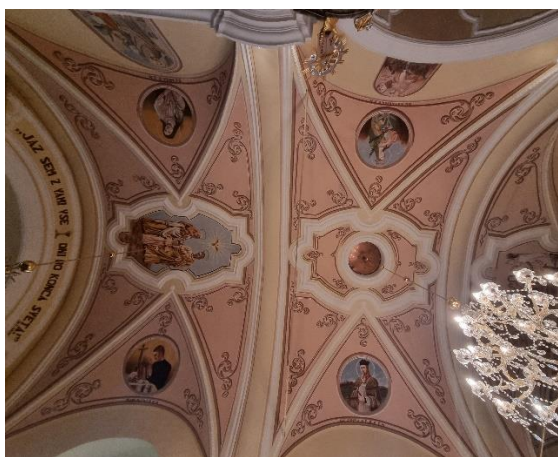
SLIKA 37: Pogled na strop s prečne ladje
