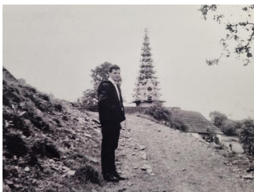
SLIKA 18: Prenova cerkvenega stolpa leta 1967
